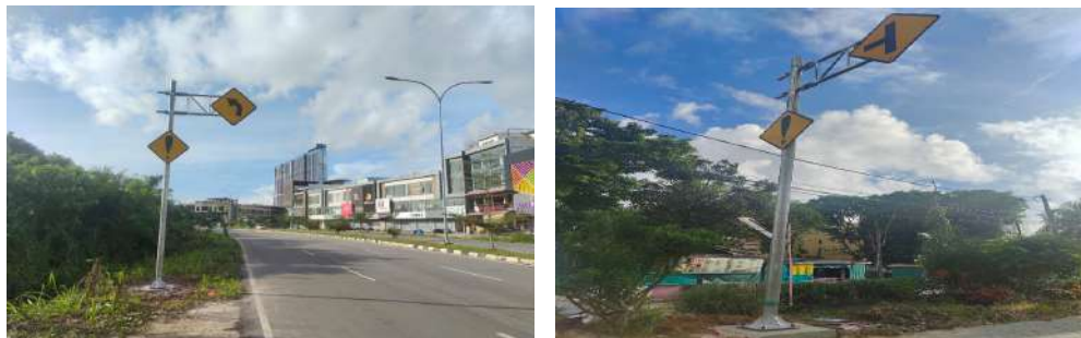
Gambar 2.1. Pemasangan Rambu Type F
