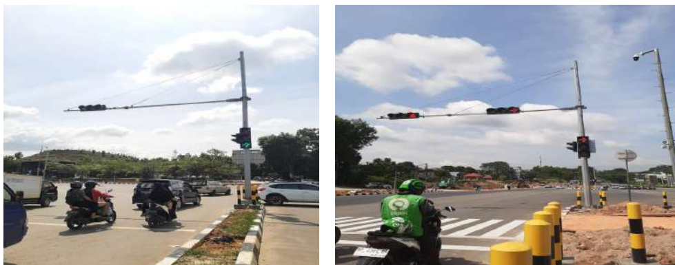
Gambar 2.3. Pembangunan Traffic Light di Simpang Tiban Princess Kecamatan Sekupang
