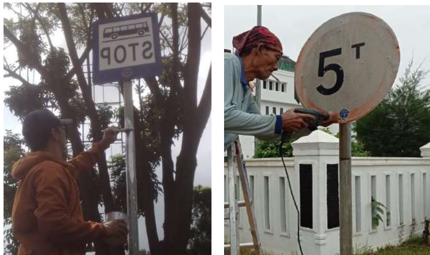
Gambar 2.6. Pelaksanaan Pekerjaan Pemeliharaan Perlengkapan Jalan Tahun 2024
