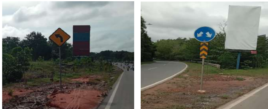
Gambar 2.3. Rambu Lalu Lintas Standar (Pembangunan Tahun 2024)
