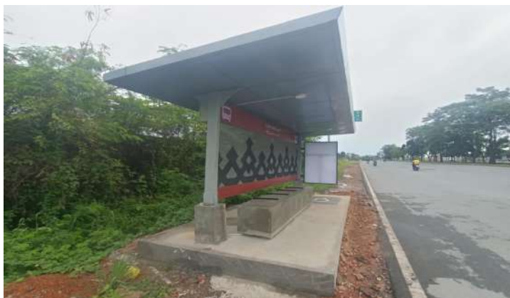
Gambar 3.11. Halte Base Camp (Pembangunan Tahun 2025)
