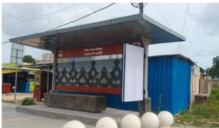
Gambar 3.15. Halte Batu Besar (Pembangunan Tahun 2025)
