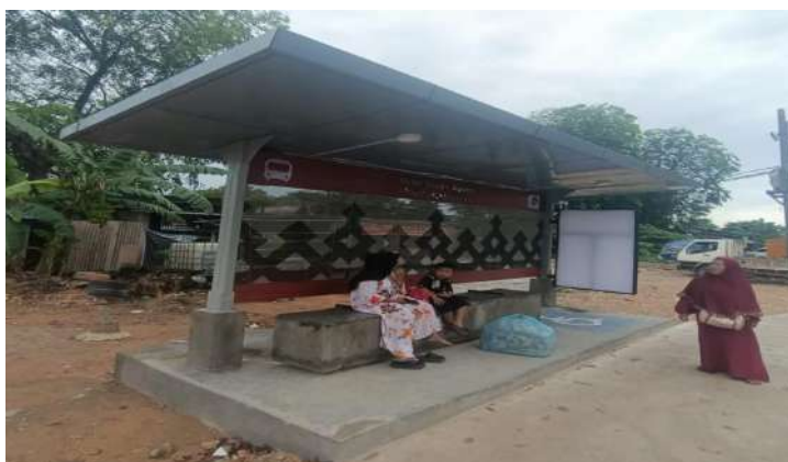
Gambar 3.12. Halte Bambu Kuning (Pembangunan Tahun 2025)
