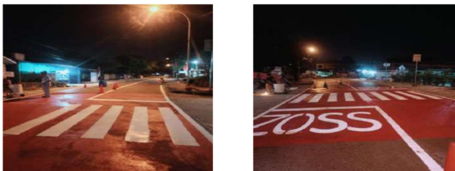
Gambar 3.27. ZoSS SDN 008 Kel. Tanjung Riau Kec. Sekupang (Pembangunan Tahun 2025)
