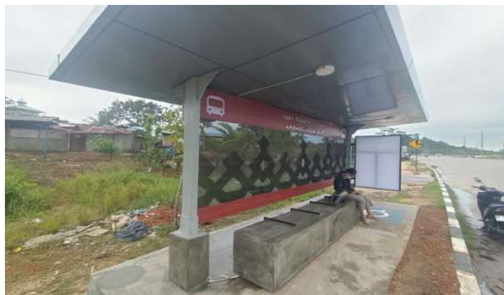
Gambar 3.9. Halte Bundaran Tembesi (Pembangunan Tahun 2025)
