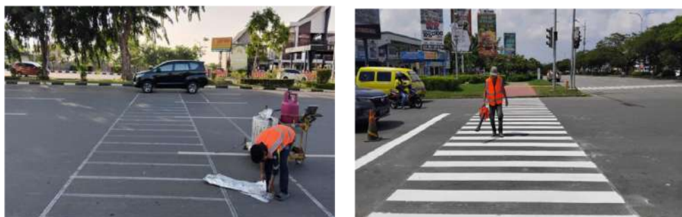
Gambar 3.33. Pengecatan Marka Jalan Tahun 2025
