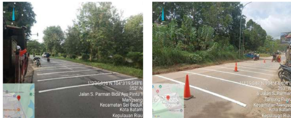
Gambar 3.34. Pengecatan Pita Penggadu Kota Batam Tahun 2025
