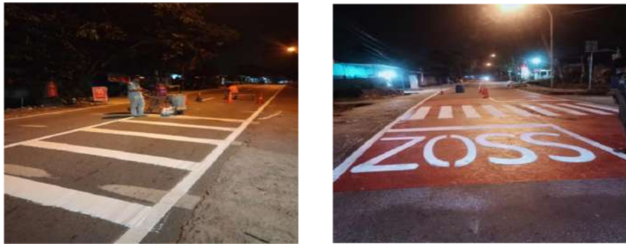
Gambar 3.28. ZoSS SDN 001 Kel. Tanjung Riau Kec. Sekupang (Pembangunan Tahun 2025)
